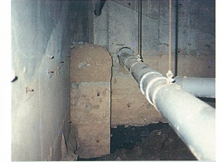
■ 地盤沈下による建物内部埋戻し
