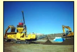
浚渫土の客土化タンク埋設(緑化)
