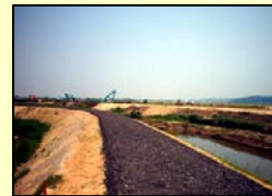
浚渫土 堤防(緑化)
