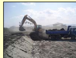
中性改良土の利用
