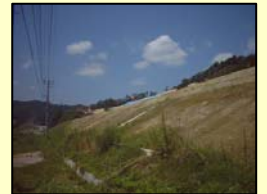
トンネルズリ 盛土
