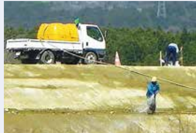
タンクと動力噴射器をトラックに積載して希釈液を作成し法面に散布
