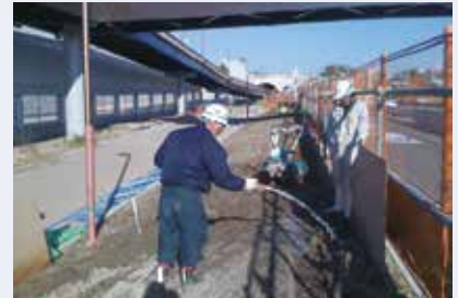
道路緑地帯への散布と養生
