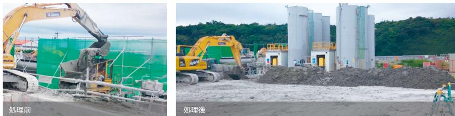
ユニット型（40m<sup>3</sup>/h）自硬性汚泥処理状況
