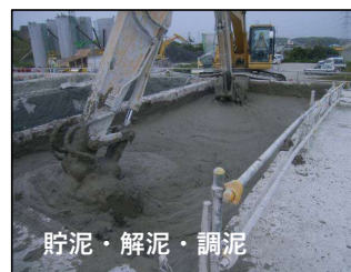
セパレート型（100m 3 /h）非硬性汚泥処理図（浚渫土）
