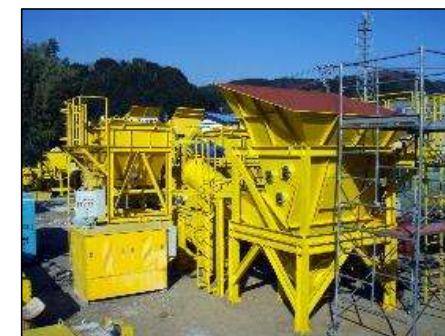
後方より設置状況
