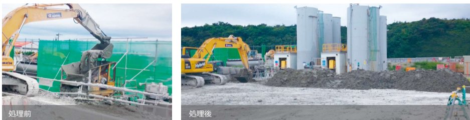
ユニット型（40m 3 /h）自硬性汚泥処理状況
