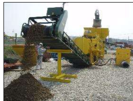
前方より設置状況
