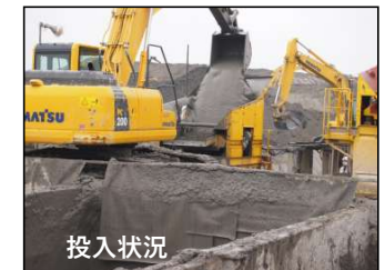
セパレート型（100m 3 /h）非硬性汚泥処理図（浚渫土）
