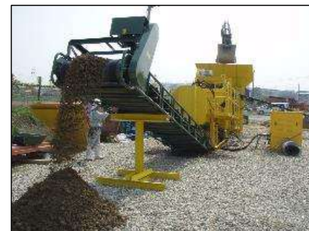
前方より設置状況
