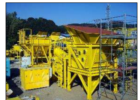
後方より設置状況
