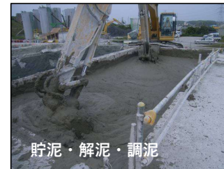
セパレート型（100m 3 /h）非硬性汚泥処理図（浚渫土）
